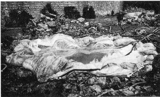
Mit Plastictüchern inmitten von Trümmern improvisiertes Löschwasserbecken
