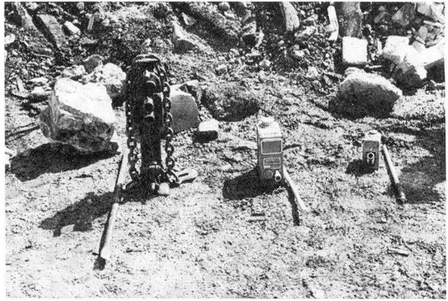
*Immer besser bewähren sich neue Modelle von Hebezeugen. Unser Bild zeigt die Modelle Simplex, Tangya und Webtool, wobei das Modell Webtool, das bis zu 12 Tonnen hebt, besonders harten Prüfungen unterzogen wurde*
