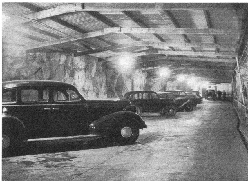
Blick in einen der Gänge, die unter der schwedischen Hauptstadt zu den grossen, in den Granit gesprengten Schutzräumen führen, die bis zu 20 000 Menschen aufnehmen können. Heute sind diese Räume als Garagen und Magazine vermietet.
