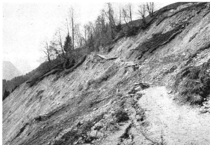
Zerstörtes Alpsträsschen Notdürftige Instandstellungen, die immer wieder beschädigt werden.
