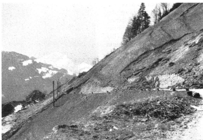
Die Alpstrasse beim Uebergang ins Rutschgebiet Der fruchtbare Humusboden ist abgesunken und rutscht gegen das Schraubachtobel hinunter.
