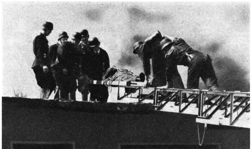
Löschen und Rettung waren die Aufgaben der Feuerwehren, die wir hier beim Abtransport eines Verletzten von einem Dach beobachten.
