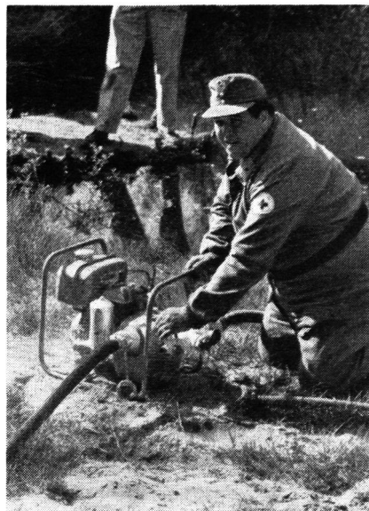
Der Saugkopf wird in das Schmutzwasser, einen Tümpel, geworfen, eine Motorspritze führt das Wasser dem Aufbereitungsgerät im VW-Bus zu.
