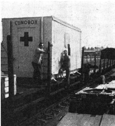
Die CLINOBOX (reg. int. Warenzeichen) wird zusammengelegt, mit Lastwagen, Bahn oder schwerem Helikopter zur Einsatzstelle befördert, dort aufgeklappt und ist in weniger als einer Stunde voll betriebs- und operationsbereit. Die gesamte medizinische Ausrüstung wird im Mittelteil mitgeführt, so dass mittlere und schwere Operationen unabhängig von Ortsanschlüssen usw. ausgeführt werden können.
