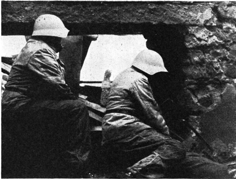
Nach den brennenden Trümmern stellen sich die ersten Hindernisse in den Weg, wie grosse Balken und Bretter, Stahlträger und Mauerwerk, welche die Durchgänge versperren und weggeräumt werden müssen.
