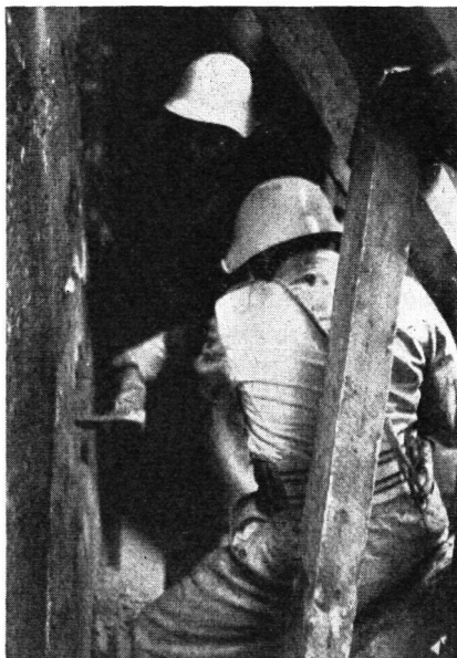
Das weitere Vordringen zu den Verschütteten wird durch eine Mauer behindert. In der Enge dieses schmalen Durchganges bemühen sich zwei Kameraden, die im Wechsel abgelöst werden, einen Mauerdurchbruch zu schlagen.
