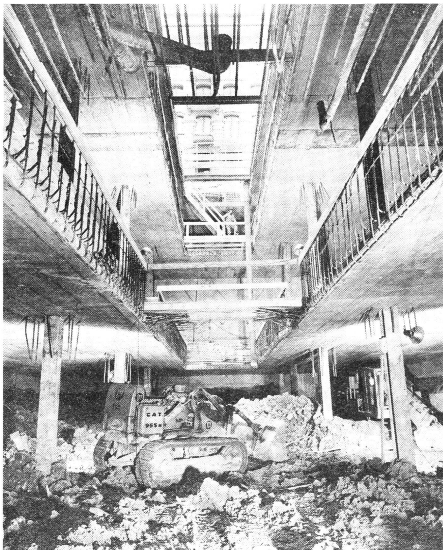
Aushub des Kulturgüterschutzraumes im 5. Untergeschoss
