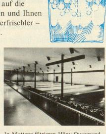
Auf Grap Sogn Gion wird Betriebssicherheit der Wasserversorgungsanlage gross geschrieben. Häny-Ingenieure haben auch hier eine Wasseraufbereitungsanlage und Pumpen projektiert und realisiert. In Muttenz filtrieren Häny-Quarzsandfilter täglich rund 200000 m³ Wasser (Versorgungsgrundlage der Region Basel). Das Rohwasser wird dem Rhein entnommen, über offene Filter geleitet und zur Anreicherung des Grundwasserstromes im Hardwald zur Versickerung gebracht.
