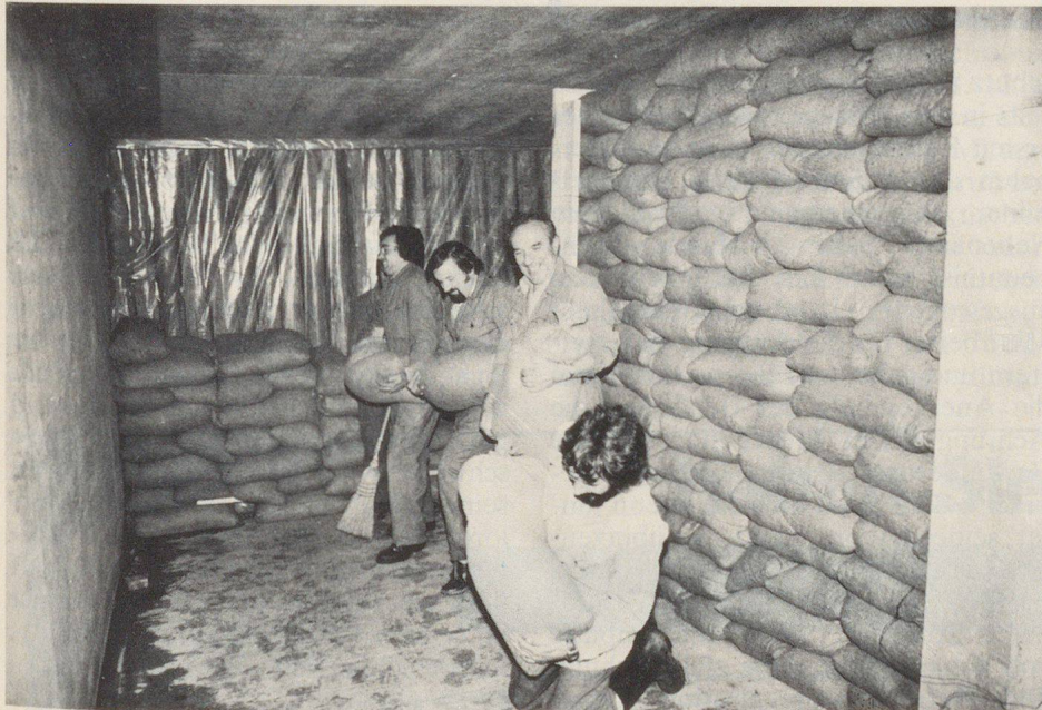
Druck- und Gasschutzabdichtung Rampe Autoeinstellhalle Kassematte
