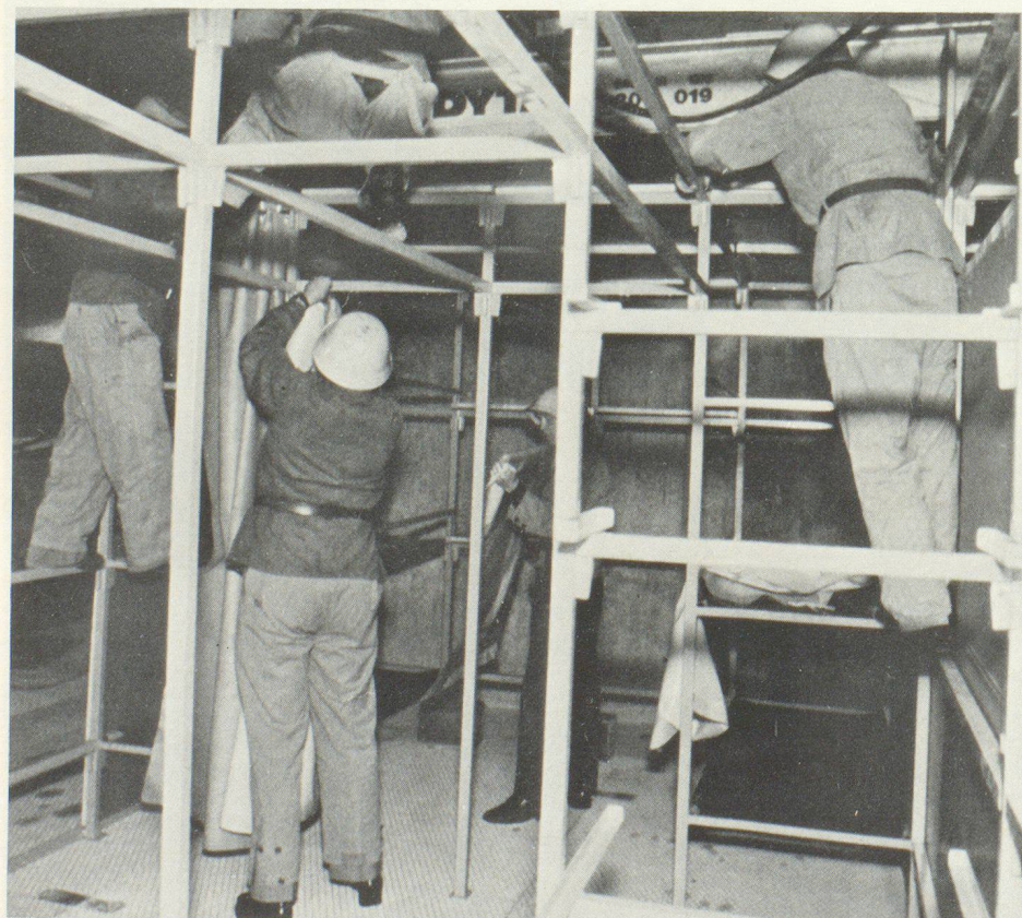
Etwas Übung im Klettern kann beim Zusammensetzen der Metallbauteile nicht schaden.
