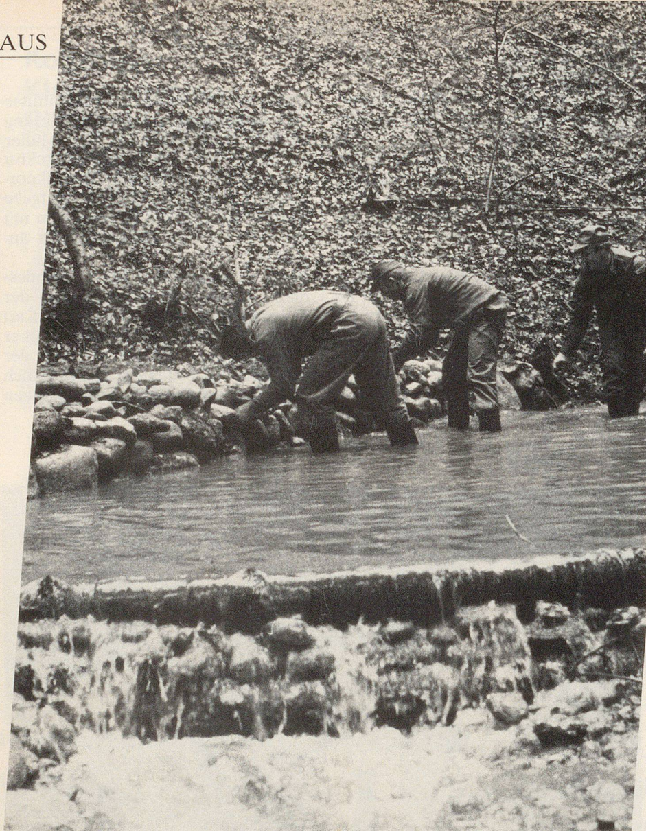
Bachverbauungen – auch mit Stiefeln eine nasse Angelegenheit.
