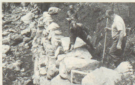
Consolidation du lit d'un ruisseau dans la commune de Saxeten (100 habitants), près d'Interlaken: les hommes de la protection civile de Muri BE empilent des pierres les unes sur les autres afin que le ruisseau soit dompté pour toujours. (Photo: Heinz W. Müller)
