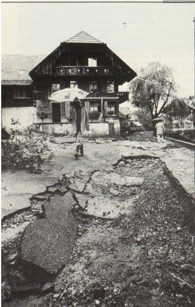
Schäden über Schäden.
