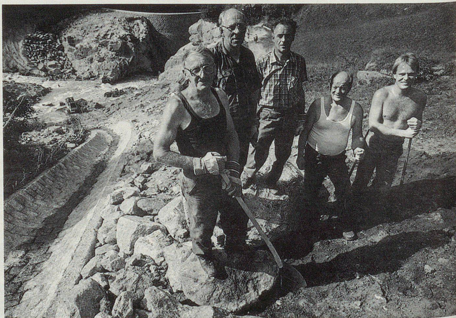
A partire dall'8 settembre, parti delle organizzazioni di protezione civile (OPC) di Affoltern a.A., Illnau-Effretikon/Kyburg e Uster e degli organismi di protezione di stabilimento (OPS) della BBC Zurigo e della Sulzer Winterthur hanno convertito gli esercizi ordinari previsti in interventi d'aiuto nei comuni di Gurtellen, Göschenen, Wassen e Realp.
