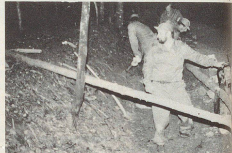
Bei der Arbeit an der Bach- und Strassenböschung.
