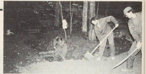
Im Vordergrund Verteilung des Wegbelages, im Hintergrund Bachstaungen.
