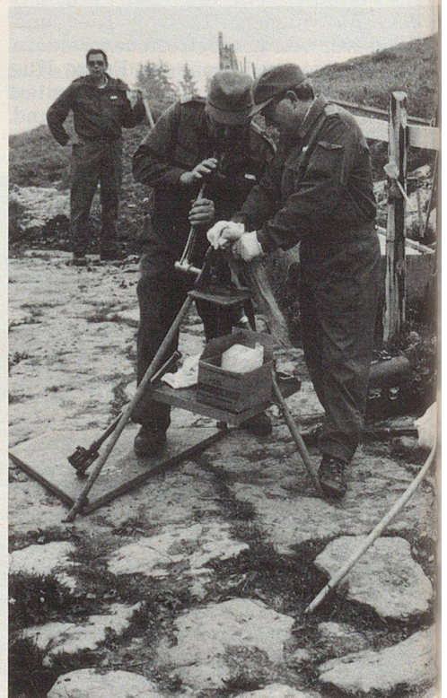
Zürcher Zivilschützer packen im Schwyzerland zu: Zwischen Ober- und Mittel-Schrot entsteht eine neue Wasserleitung von 200 Metern Länge.
