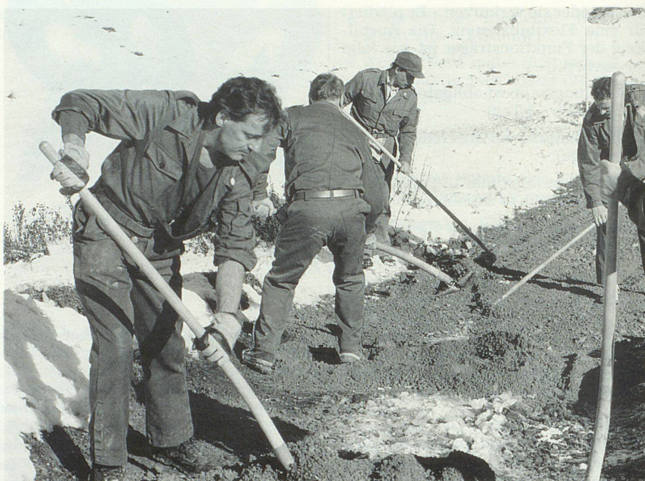
Eine zuvor erstellte Loipe wird mit Kies ausgeebnet und verdichtet.
