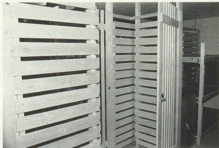
Keller-Unterteilungen werden mit wenigen Handgriffen... ... zu vorschriftsmässigen Schutzraum-Einrichtungen. (Fotos: K. Glarner)
