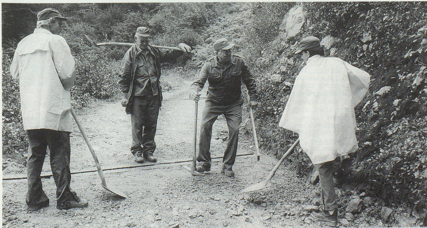
Strassensanierung mit Schaufel und Pickel.
