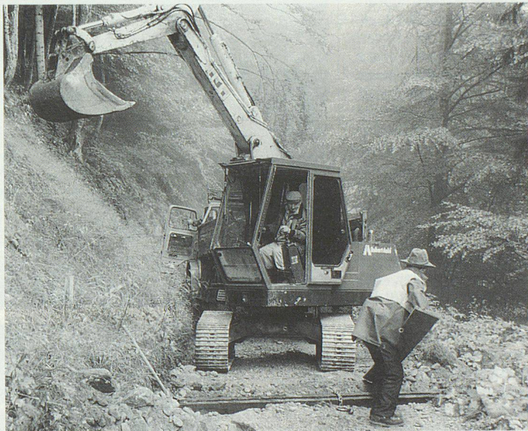
Massive Querrinnen aus Eisenbahnschwellen wurden eingebracht. (Fotos: Urner Wochenblatt)
