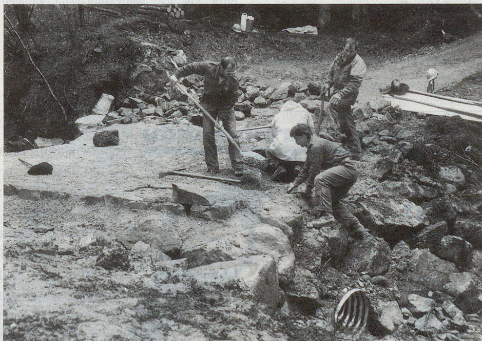
Im Gebiet «Bödeli» wurde der Bach mit einer Furt überbrückt.
