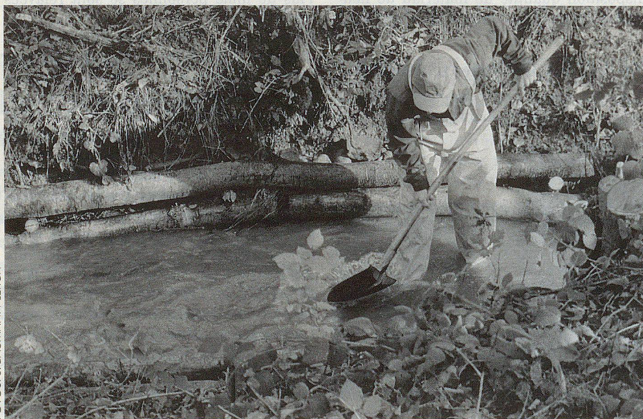
Ausgerodetes Ufergehölz wird teilweise für die Verbauungen der unterspülten Bachufer verwendet.
