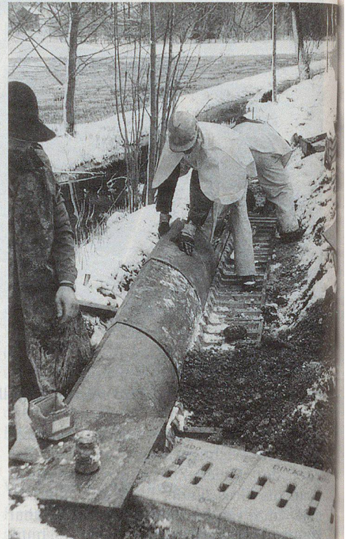
Über 300 Meter Leitwände und Amphibientunnel wurden verlegt.
