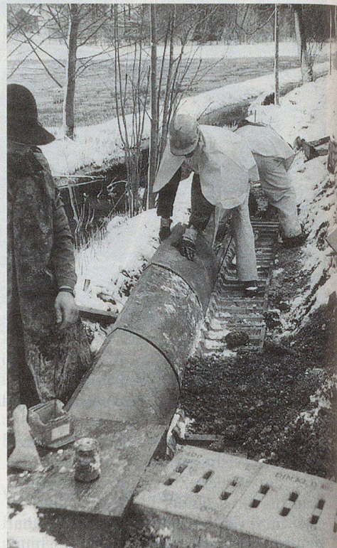
Über 300 Meter Leitwände und Amphibientunnel wurden verlegt.
