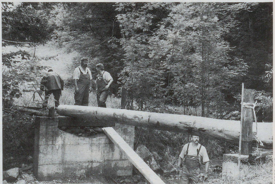
Zivilschützer erstellen eine massive Holzbrücke.
