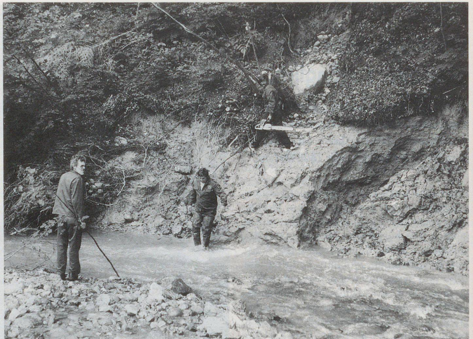
Der Bach wird von Holz und Schwemmaterial befreit.
