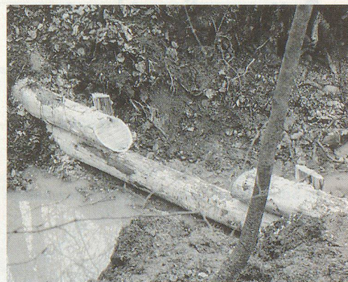
Eine der fachgerecht erstellten Bachverbauungen.
