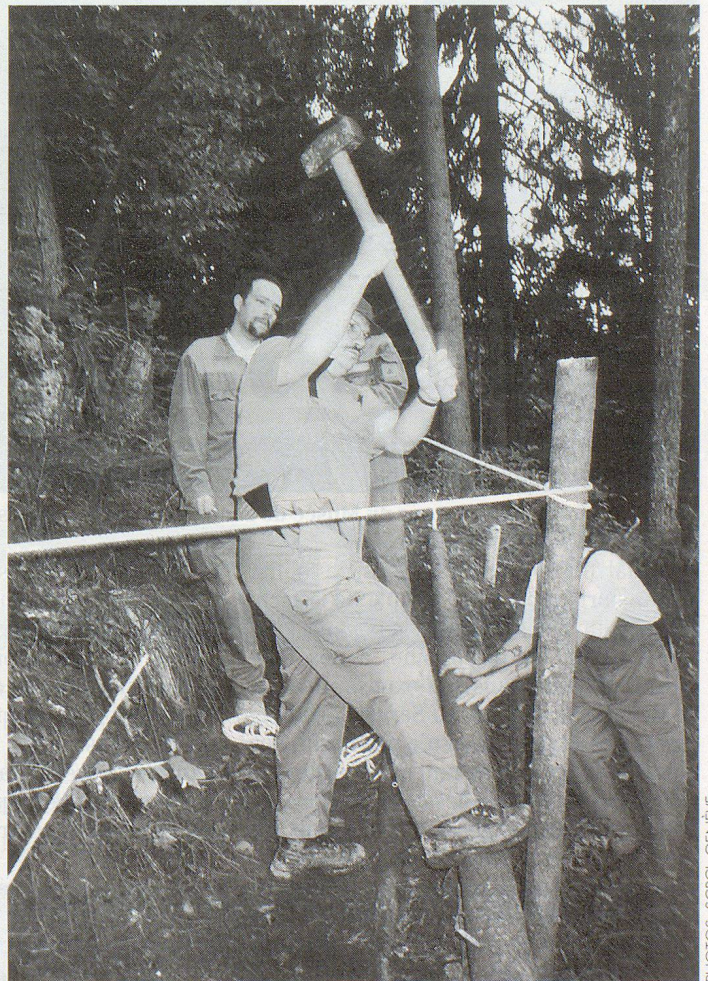
... pose des rondins et consolidation du chemin.
