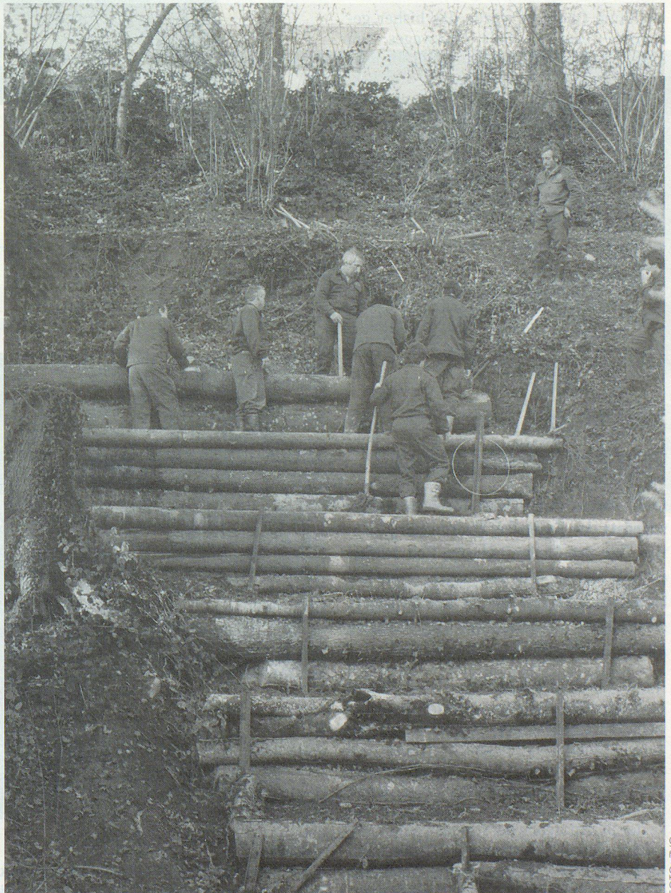
Massive Verbauung eines abgerutschten Hanges in Häggenchwil.
