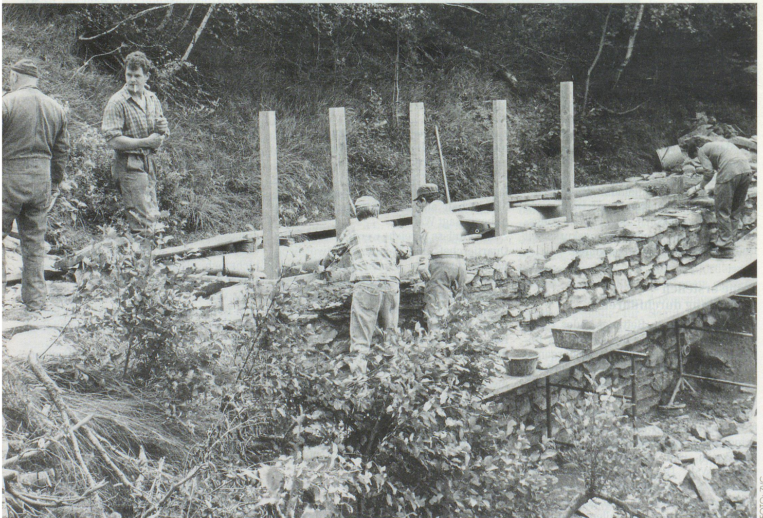
Angehörige der Zivilschutzorganisation Buchs beim Bau einer Bruchsteinmauer in Ausserberg.
