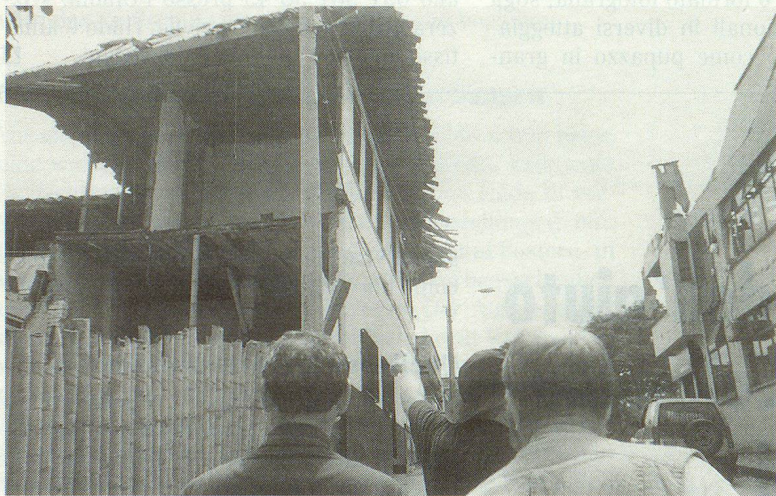
Tipico quadro dei danni dopo un sisma di 6,2 gradi sulla scala Richter: crolli parziali in seguito a costruzioni a tappe.
