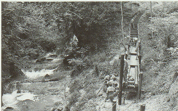
On refait la structure du pont descendant de la route cantonale...
