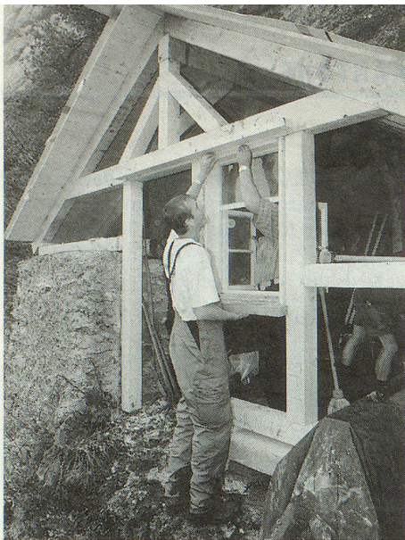
Zivilschützer bauen die Schrennen-Hütte neu auf.
