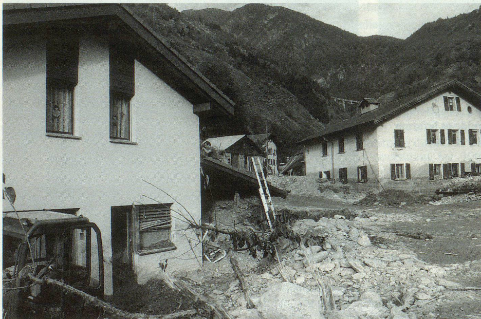
Une idée de la hauteur et des matériaux laissé par la vague.
