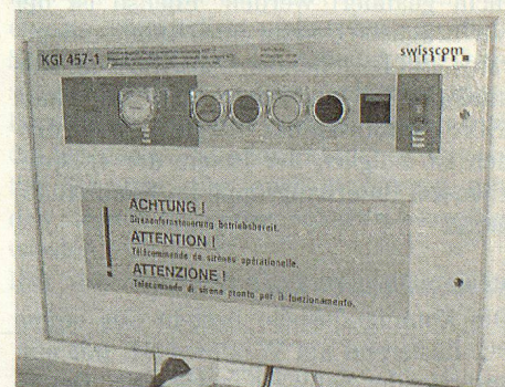
Bild 2: Kommandogerät mit Tasten und Schalter für zehn Alarmierungsbereiche.
