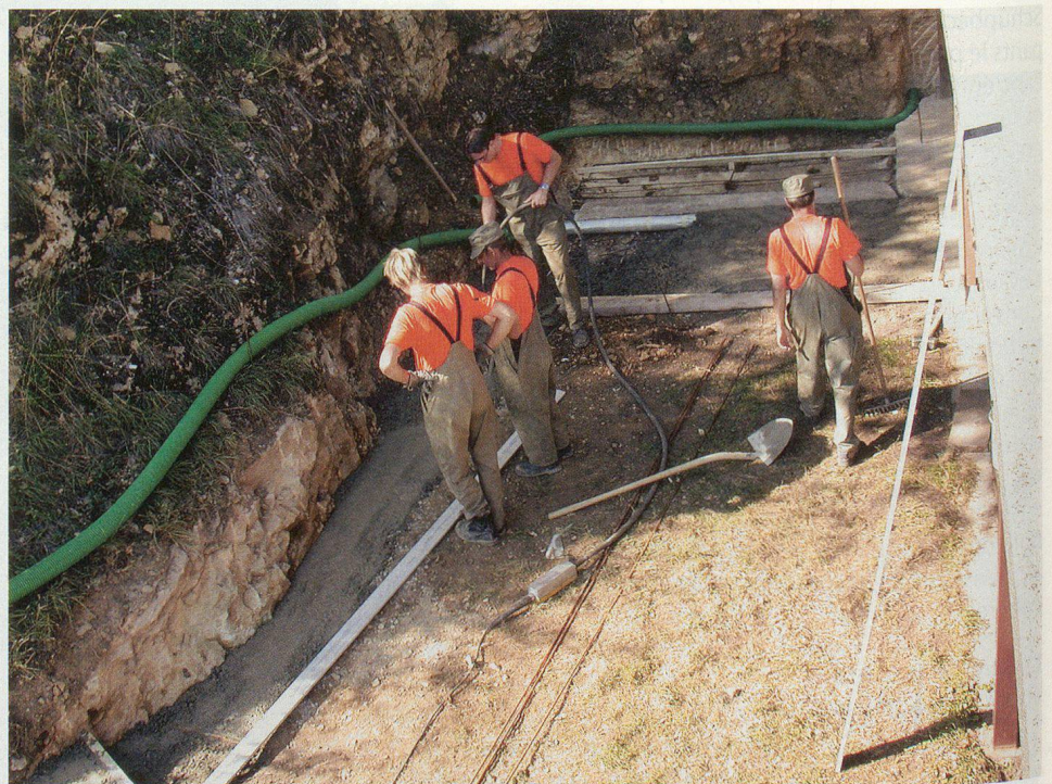
Assainissement: construction d'un mur et d'un drain.
