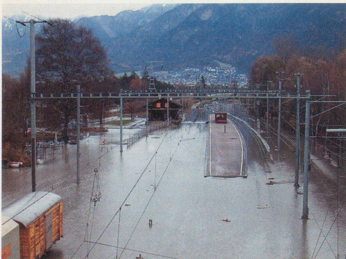
Der Bahnhof Felsberg unter Wasser.
