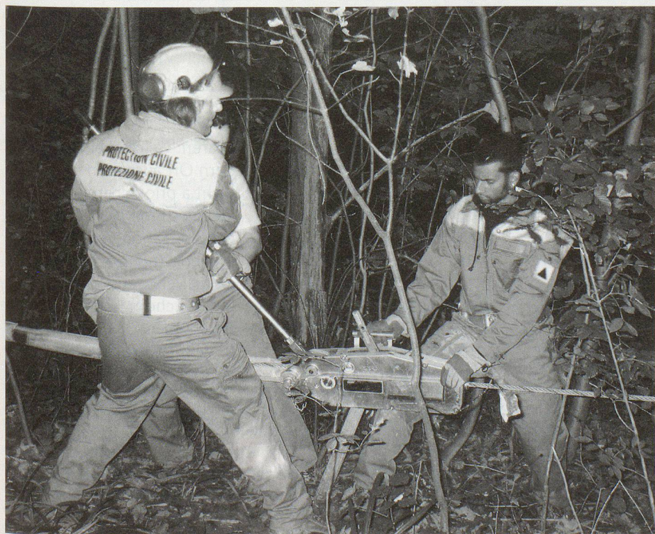
Unwetterschäden werden behoben.
