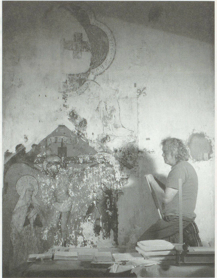
Umfassende Restaurierungsarbeiten im Innern der Kathedrale von Chur.
