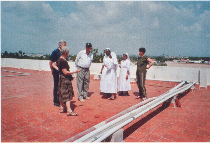
Kostbares Gut: Auf dem flachen Hausdach wird Regenwasser gesammelt und mittels offen verlegter Rohre in die Tanks geleitet.
