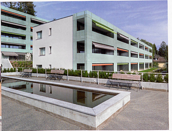
Wohnappartements mit grosszügigen Balkonen
