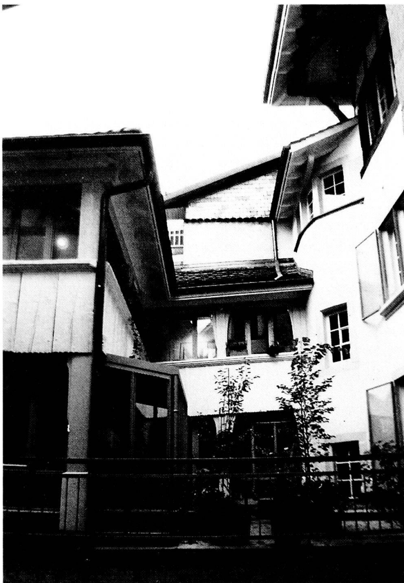
Innenhof des Hauses Münster- gasse 30 mit neu befenstertem Hofgebäude, aufgestocktem Treppenturm und Rückfassade des Hauptgebäudes mit Auf- zugsgebel.
