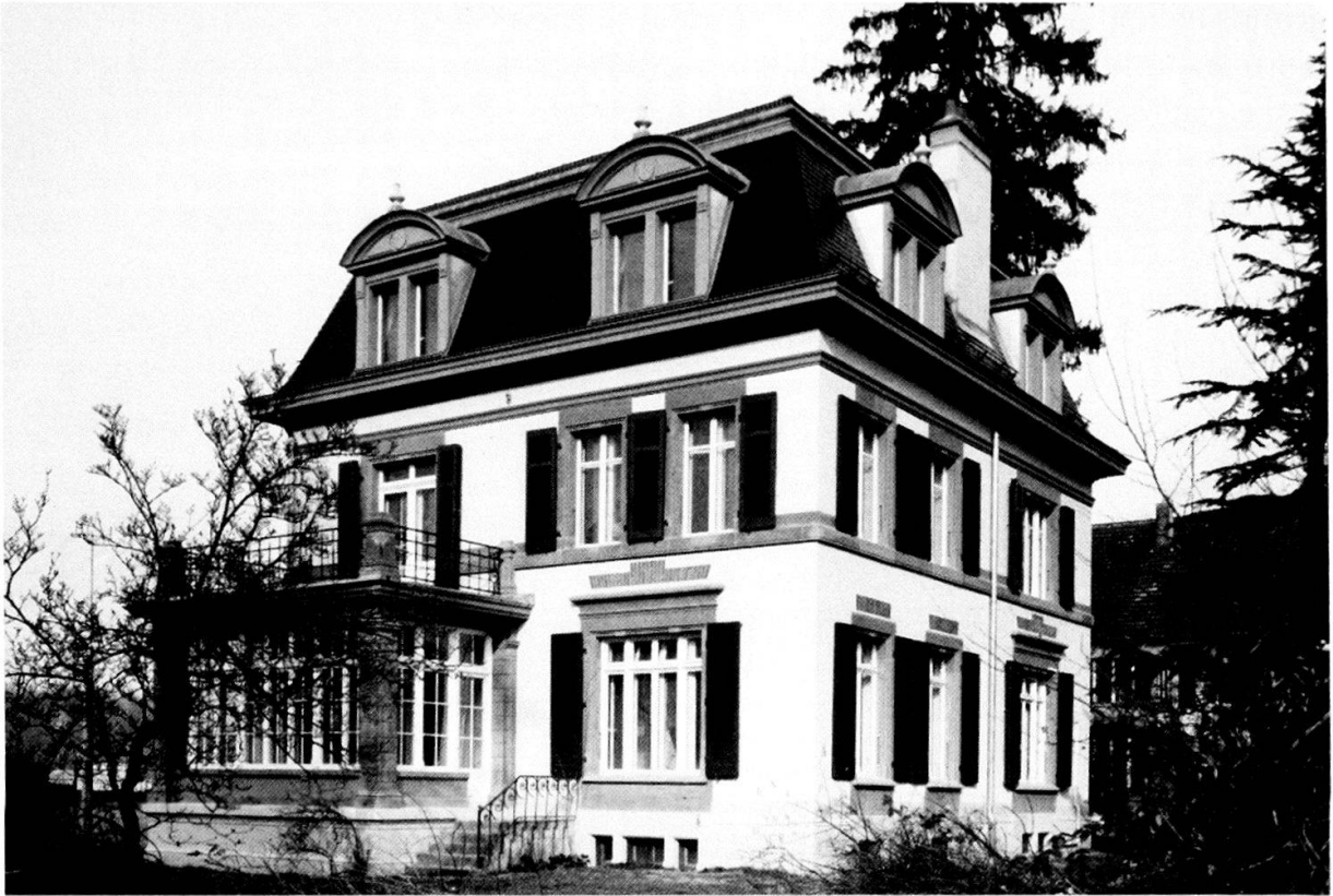
Neubarocke Villa Beaulieustrasse 72 nach der Renovation 1992.
