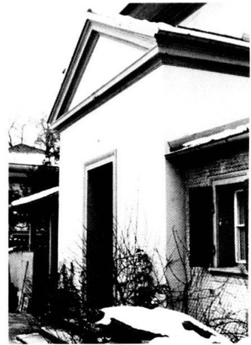
Schiferli-Gut: Der klassizistische Portikus vor dem Abbruch.
