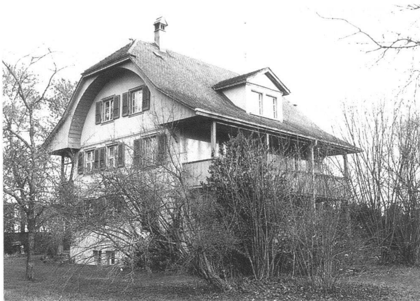
Reichenbachstrasse 87: Das von den Architekten Nigst & Padel 1928/29 erstellte Wohnhaus im Zustand vor dem Abbruch.
