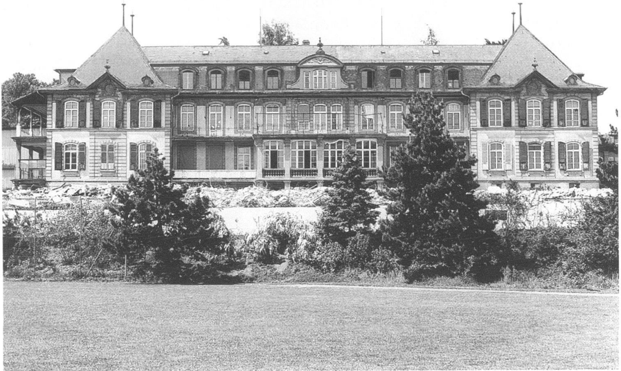
Freiburgstrasse 21–25: Fotomontage der Südfassade des «Jenner- Spitals» vor dem Abbruch.
