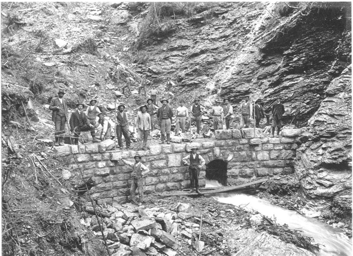
Abb. 8 Arbeiter beim Bau einer Sperre für einen Wildbach um 1910. Im Hintergrund lauert die Wildnis des Bachbettes, im Vordergrund herrscht Ordnung. Die Natur zu beherrschen, bedeutete Fortschritt und war für die Sicherheit der BLS-Strecke wichtig.
