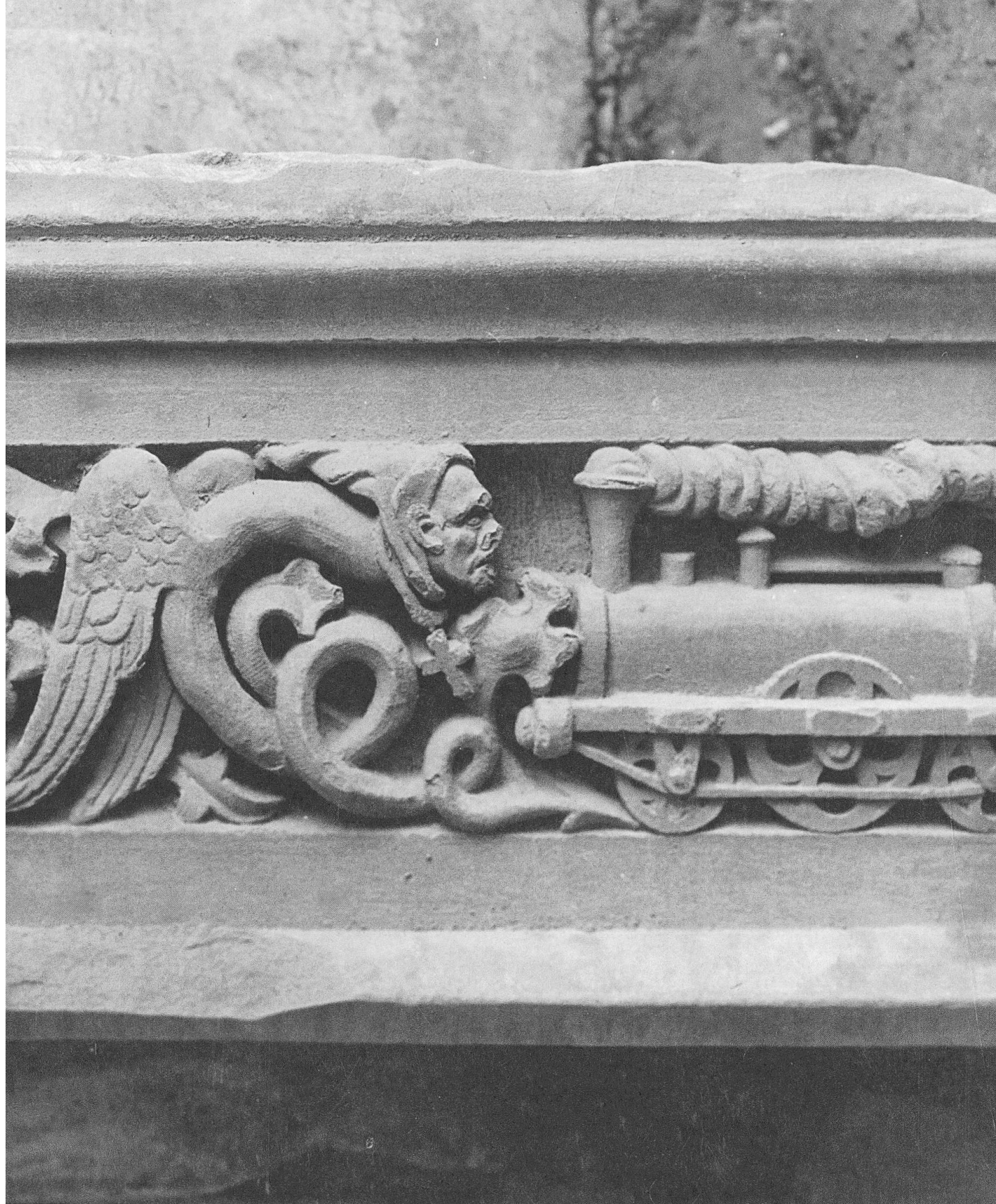
Umbau Rathaus 1940–1942: Die Aussenhülle des Berner Rathauses war 1865–1867 von Kantonsbaumeister Friedrich Salvisberg in neugotischem Stil umgestaltet worden, durchaus dem Geschmack der damaligen Zeit entsprechend. Das Fragment eines Frieses der abgebrochenen Hoffassade zeigt in neugotischem Rankwerk eine – damals hochmoderne – Dampflokomotive. – StAB, BB 05.7.846, Nr. 75. Foto: Martin Hesse, 24.10.1940.
