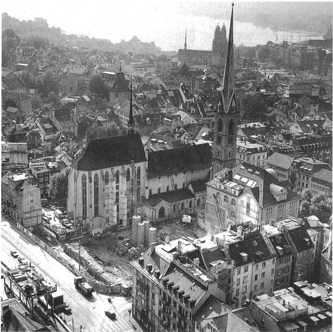
Abb. 2 Die Baustelle der neuen Zentralbibliothek eröffnete einen ungewöhnten Blick auf die Predigerkirche. Unten links nach Abbruch der Seilergrabenhäuser die Reste der Stadtmauer aus dem 13. Jahrhundert.
