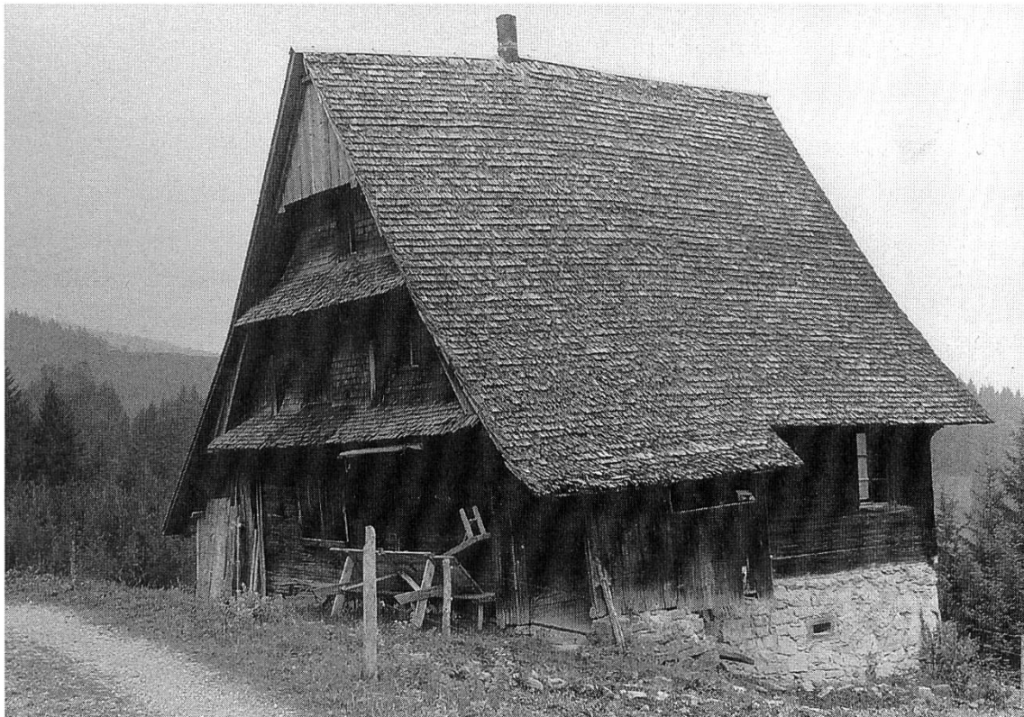
Abb. 4 Galgenen, Wiselegg: Wohnhaus mit steilem Dach und aufge- nagelten Schindeln (Foto B. Furrer, 1986).
