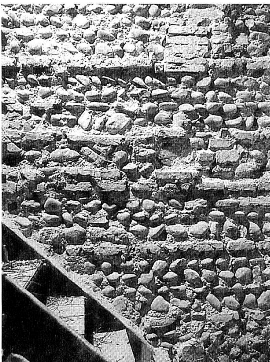
Abb. 9 Backstein- bänder in einem Basler Haus, 1. Hälfte 15. Jh.
