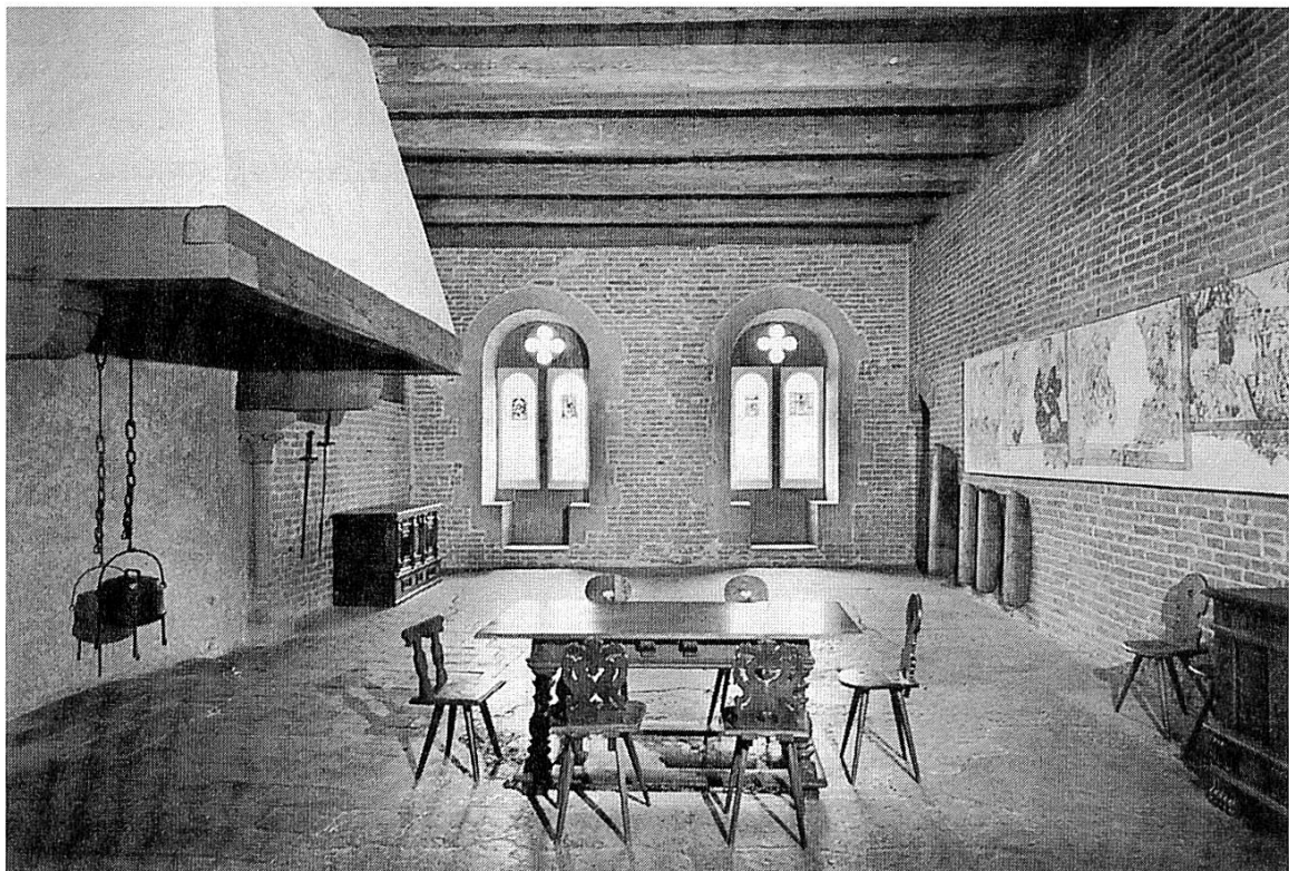
Abb. 8 Backstein- mauer im Rittersaal der Burg von Burgdorf um 1210.
