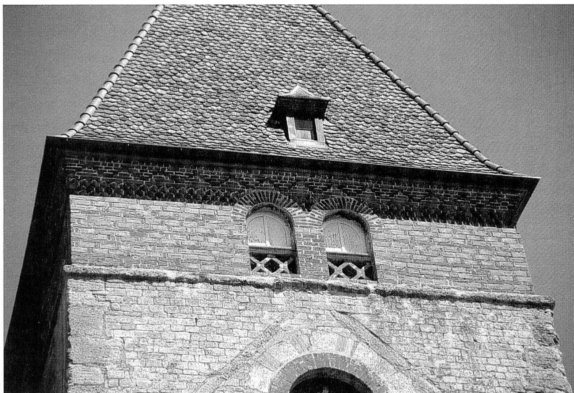
Abb. 11 Spätgotische Aufstockung des ehem. Vierungs- turms von München- wiler BE, nach 1553.
