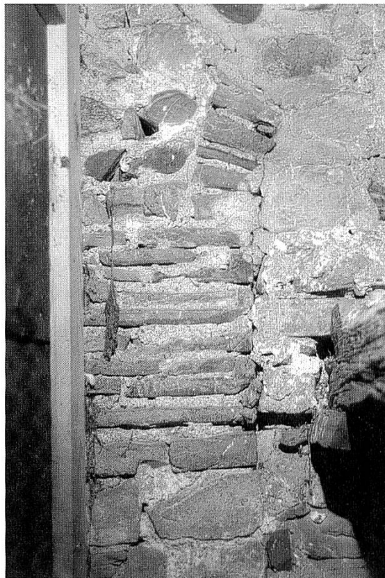
Abb. 6 Ziegelmauerwerk der ehemaligen Schallöffnung im 3. Turmgeschoss, gegen Osten.
