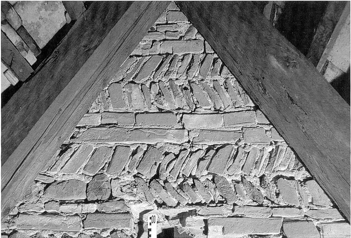
Abb. 4 Östliche Giebel- scheibe mit Ziegelfrag- menten im Dachraum des Chors, gegen Westen.
