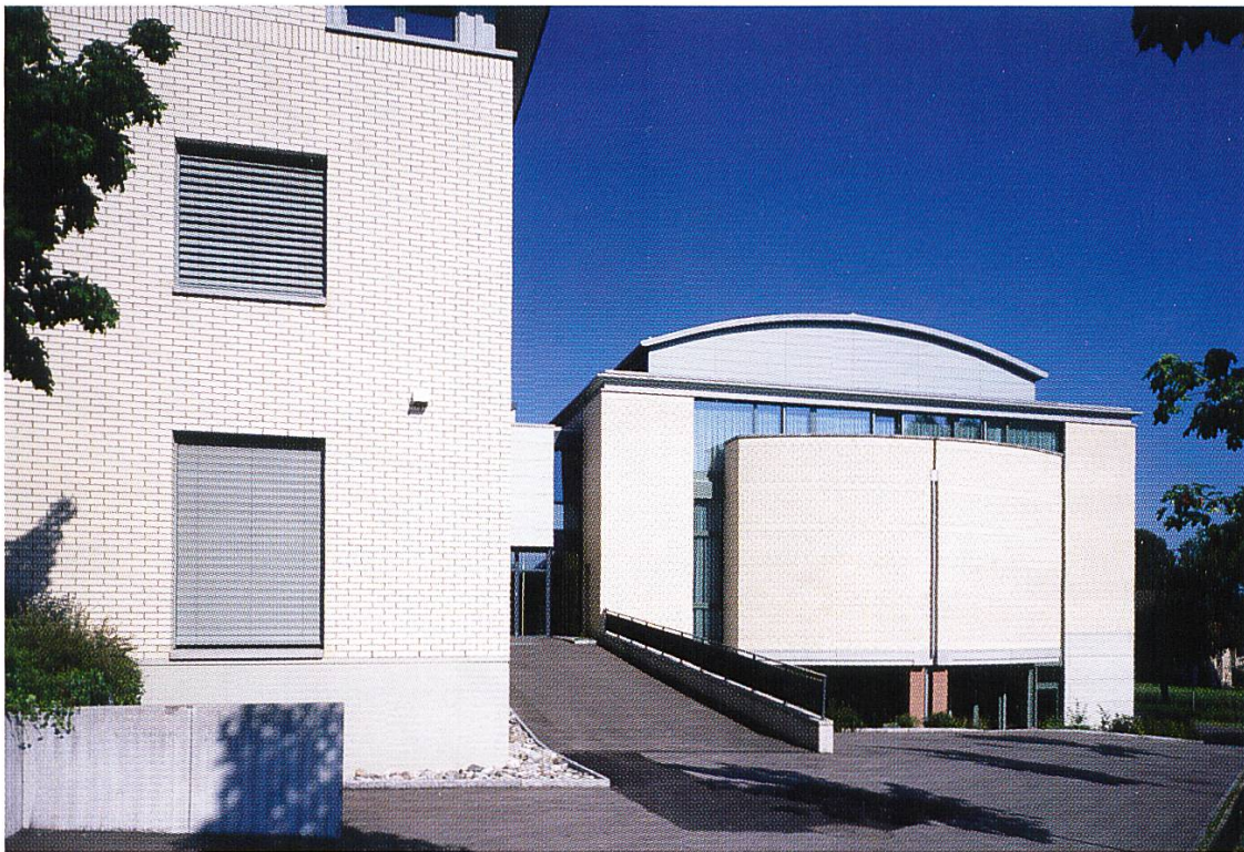
Abb.5 Kleinformatige weiße Sichtsteine lassen die Fassaden dieses Gemeindezentrums wie ein feingestricktes Muster erscheinen, das durch Bänder von in senkrechter Position vermauerten Sichtsteinen (Rollschichten) unterbrochen wird.
