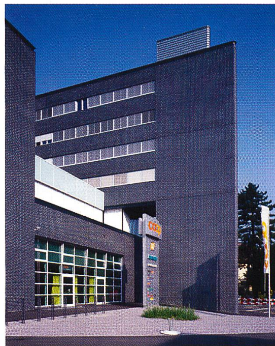
Abb. 9 Schwarze Klinkersteine waren bis vor kurzem nur in den nordeuropäischen Ländern anzutreffen. Nun liegen diese Farbtöne auch hierzulande im Trend, wie dieser kürzlich erstellte Bau in Zürich-Oerlikon zeigt.
